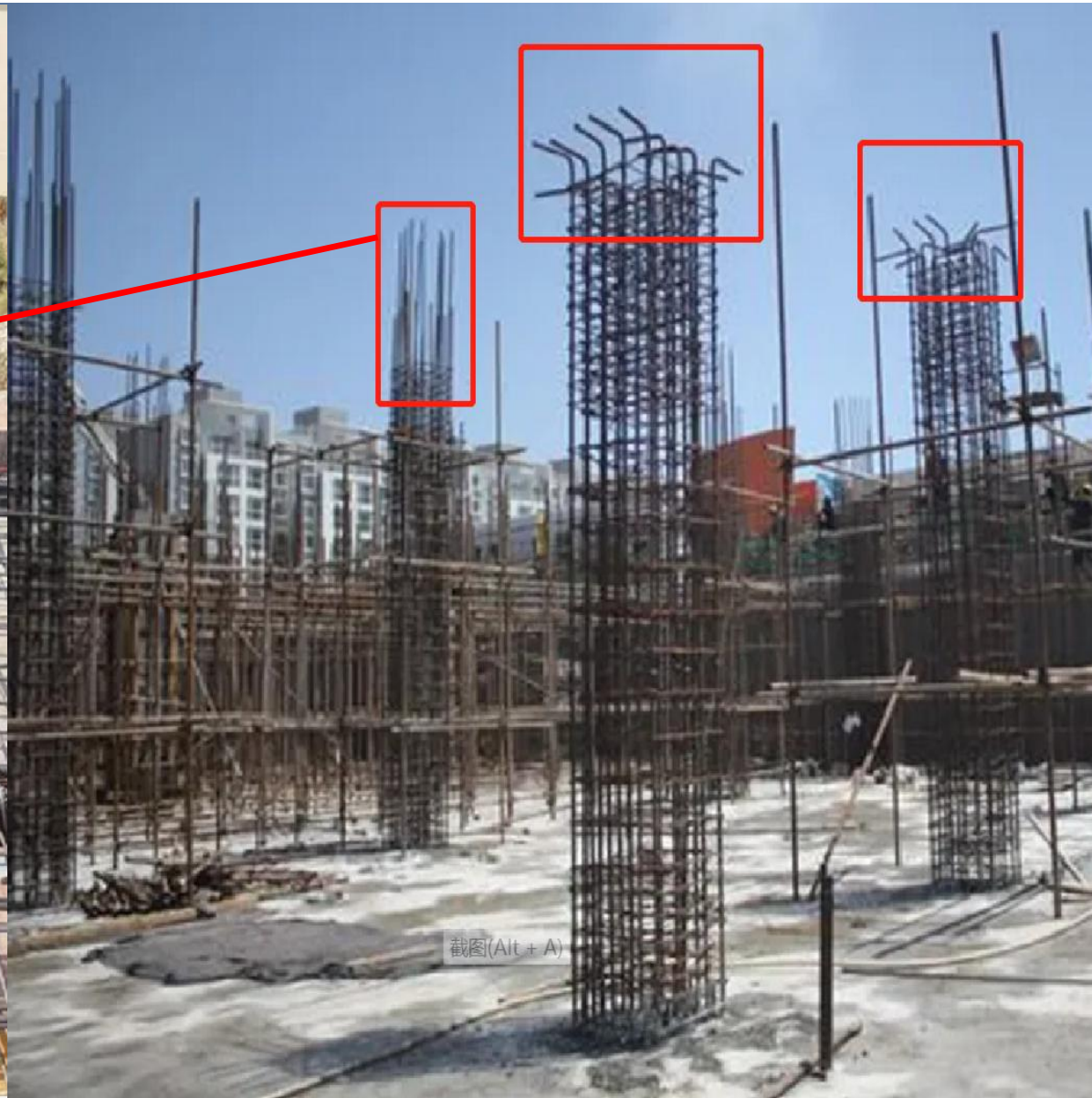
中柱顶层钢筋示意图
