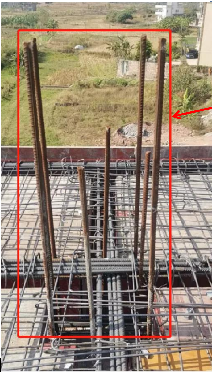
柱中间层钢筋示意图
