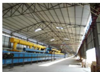
钢结构厂房结构安全性鉴定
