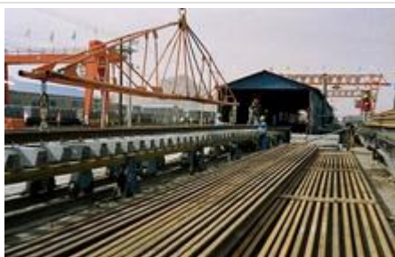
南山口铺架基地
