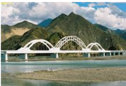
青藏铁路标志--拉萨河特大桥
