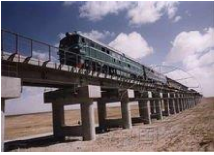
清水河特大桥
