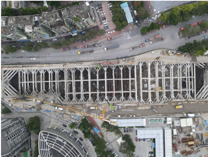
图 4-4 广州市轨道交通五号线东延段黄埔新港站施工现场状况
